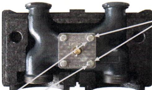
Die zwei Schrauben rechts auf der Mischerplatte entfernen.
