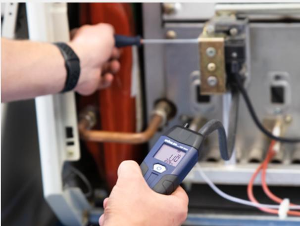
Düsendruckeinstellung am Gasbrenner
