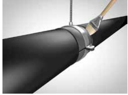
Einbau der Rohrleitungen, wobei nur die PET-Segmente zur Auflagerung benutzt werden dürfen.
