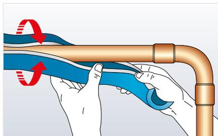
ArmaFlex Ultima so auf der Rohrleitung positionieren, dass die geschlitzte Fläche zugänglich ist.
