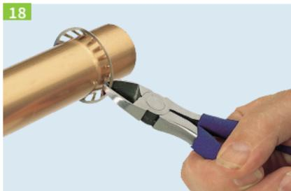
**18.** Trennen der Haltekralle mit einem Seitenschneider und entfernen.
