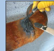
7. Neue Portion anmischen und eine 3-5 mm Schicht auftragen.
