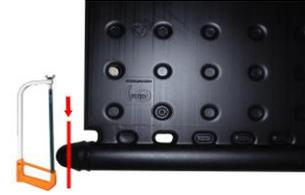
2. OKU-Absorber auf der vorgesehenen Fläche auslegen und gemäß Anschlußschema mit Verbindungsstücken und Schlauchschellen verbinden. Bei Schrägdächern von oben anfangen und zugleich auch Zug um Zug die Dachbefestigung durchführen, um ein Wegrutschen der Absorber während der Arbeit zu verhindern.
