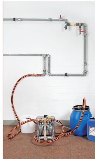
3. Nach ordnungsgemäßer Befüllung ist die Leitung mit 4 bar zuzüglich 1 bar je 10 m Höhe der abzudichtenden Installation zu beaufschlagen.
