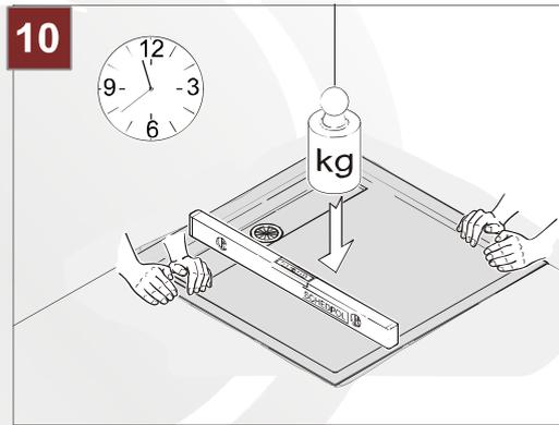
10. Nach einer ausreichenden Austrocknung des Klebers (ca. 24h) kann mit dem Verfliesen begonnen werden.
