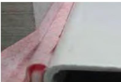
7. Nun den Butylklebestreifen an die Wand kleben. Der Wasserschutzstreifen muss dann mind. um 5 cm von der Fliese über-deckt werden.
