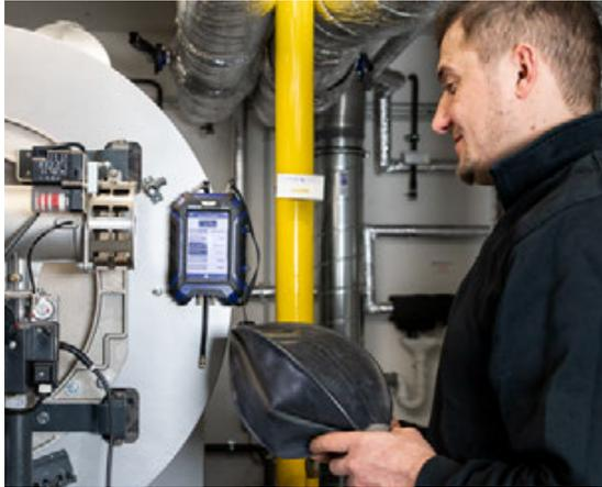
Die Gebrauchsfähigkeitsprüfung lässt sich sicher mit Betriebsgas durchführen, so dass die Leitung nicht gespült werden muss.
