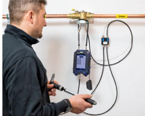
Mit dem passenden Anschluss-Zubehör wird die neu installierte Gasleitung ganz einfach mit dem Prüfdruck für die Belastungsprüfung (1 bar) beaufschlagt.
