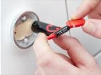
+ Tubenspitze fest und dicht in eines der Löcher stecken. Tubenende aufrollen und Haftmittel langsam einfüllen, bis es an der zweiten Öffnung sichtbar austritt. Erst dann ist die Klebstoffkammer komplett gefüllt.
