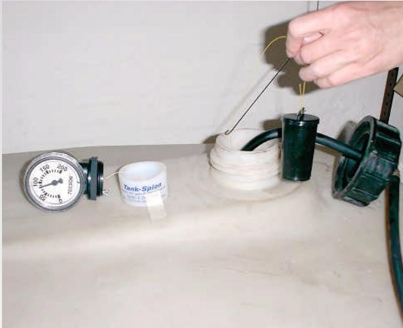
( 6 ) Anzeigerät in das aufgeklebte Halterungsteil einschrauben
