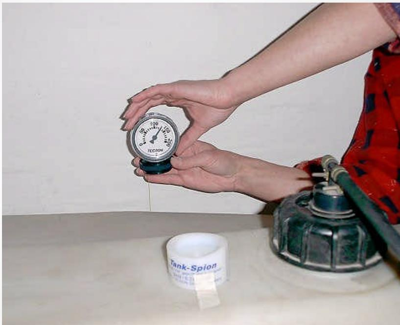
( 5 ) Meldefaden durchziehen, Schwimmer anbringen und in den Tank ablassen
