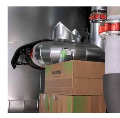
Mindestdämmschichtdicken für Lüftungsanlagen im GEG zu definieren, ist der Gesetzgeber nicht nachgekommen. Durch die zunehmende Klimatisierung von Wohn- und Nichtwohngebäuden entstehen auf un- oder nicht ausreichend gedämmten Luftkanälen erhebliche energetische Verluste im Leitungsverlauf. Die DIN 1946-6 nennt Dämmschichtdicken für Luftleitungen. Zur Vermeidung von Energieverlusten hätten die in der Tabelle 20 definierten Isolierstärken (Spalte "verbessert") in das GEG eingeführt werden können.
