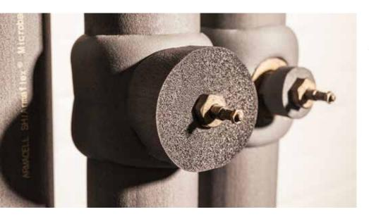
Nicht nur die Rohrleitungen, auch Armaturen, Bogen, T-Stücke und Rohrschellen müssen nach EnEV gedämmt werden.
