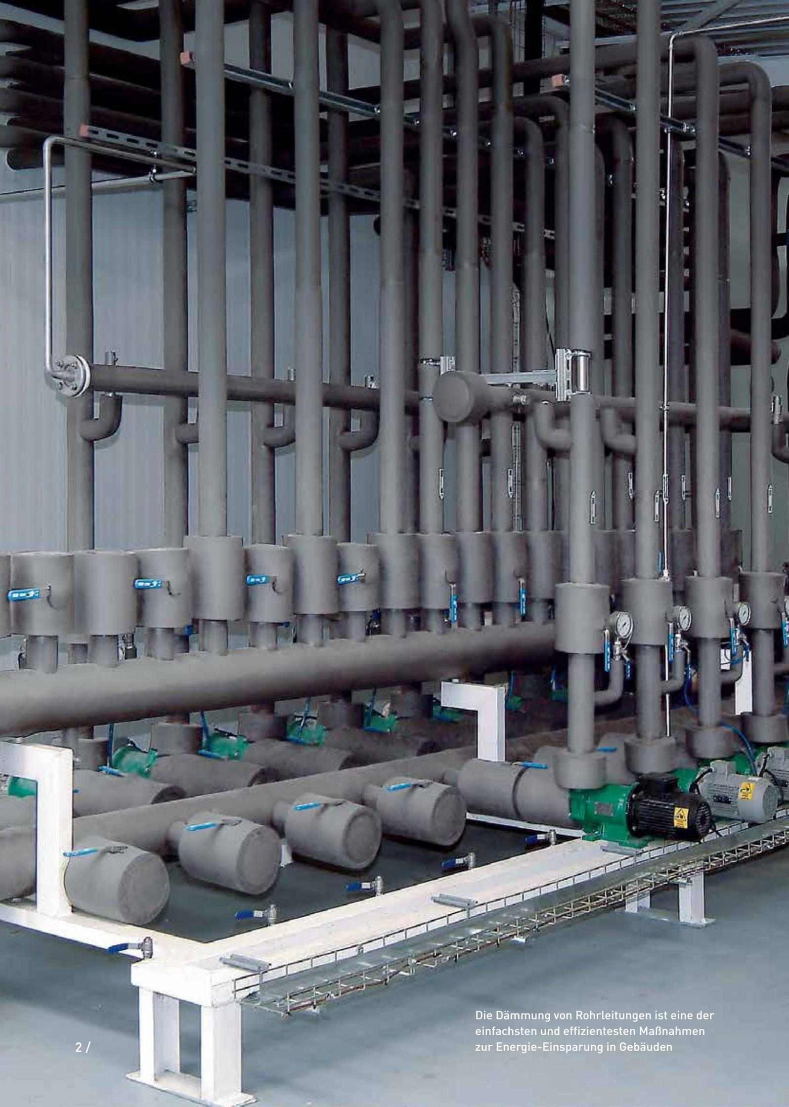
Die Dämmung von Rohrleitungen ist eine der einfachsten und effizientesten Maßnahmen zur Energie-Einsparung in Gebäuden
