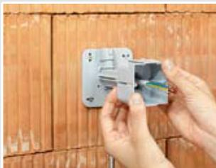
Gerätedose bis zum Anschlag auf den Trägerarm aufsetzen.
