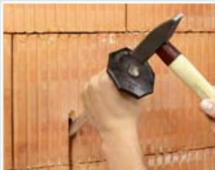
Leitungswege vorbereiten. Eine direkte Leitungsführung durch Mauerwerk und Dämmung sollte vermieden werden.
