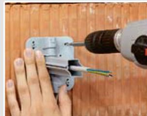
Langlöcher ermöglichen die exakte Ausrichtung auch bei ungenauen Bohrungen.
