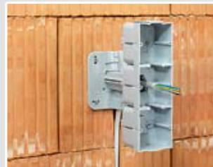
Zwei- und Dreifachkombinationen lassen sich einfach und sicher mit nur einem Träger waagrecht oder senkrecht installieren.
