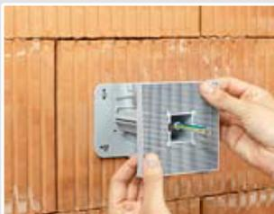
Montageplatte bis zum Anschlag auf den Trägerarm aufsetzen.
