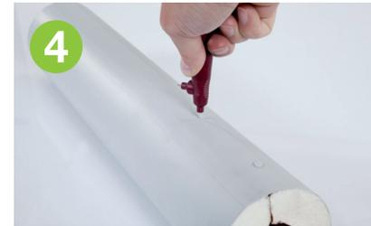
Die Überlappung der Längsnaht sollte alternativ mit Nieten verschlossen werden. Bei Umgebungstemperaturen über +40 °C und bei nachträglich unzugänglichen Leitungen sind die Nahtverklebungen zusätzlich mit Plastiknieten zu sichern (mind. 5 Stk/lfm).
