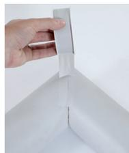
Die Längsnaht mittels der selbstklebenden Überlappung und die Stoßnähte mit passendem Klebeband verschließen.
