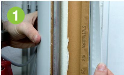
Isolierschale aufklappen und um das zu dämmende Rohr legen.
