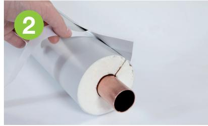
Die Längsfuge zusammendrücken, Schutzstreifen der Verschlussautomatik abziehen und Klebeband gut andrücken. **Auf trockene, staub- und fettfreie Klebestellen achten.**
