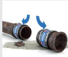
Schlauchadapter ganz über das Rohr schieben (ggf. Gleitmittel benutzen).
