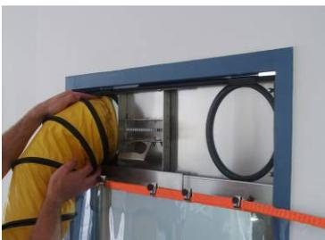
Jetzt können – je nach Anwendungsfall (s. Abschnitt 5) – ein oder zwei Schläuche (Ø 203 mm) durch die Öffnungen der DCD geführt werden.
