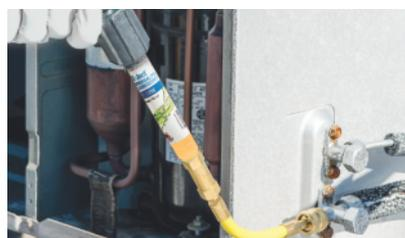
Injektion des Färbemittels durch Drehen des Griffs.
